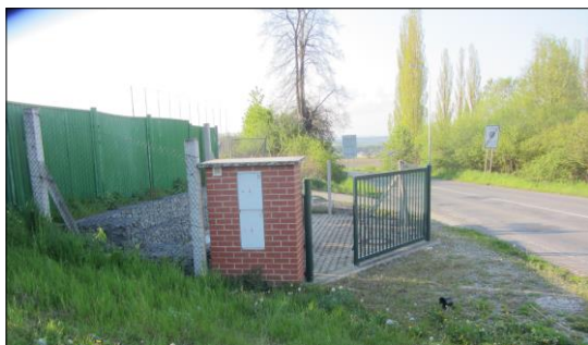
Obr.1 – nadzemní část čerpacích stanic (areál ČS s elektropilířem) – vzorová ČS
